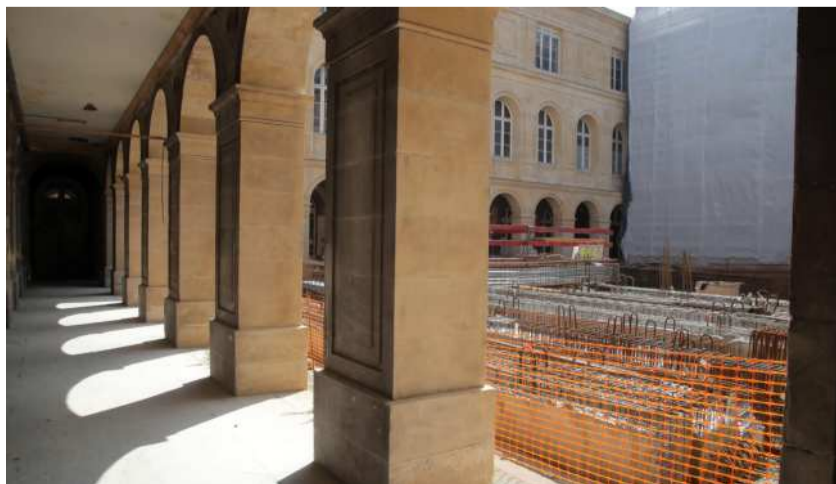
Dans l'une des quatre cours intérieures de l'îlot Casteja, havre de paix en plein centre-ville, ici promise au futur hôtel de standing
